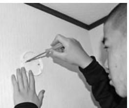
◆住警器の土台部分を、壁や天井に取り付ける。脚立に登っての作業は危ないので注意しよう。取り付ける天井や壁に土台を当て、テープなどで仮留めしておけば作業は楽だ。
