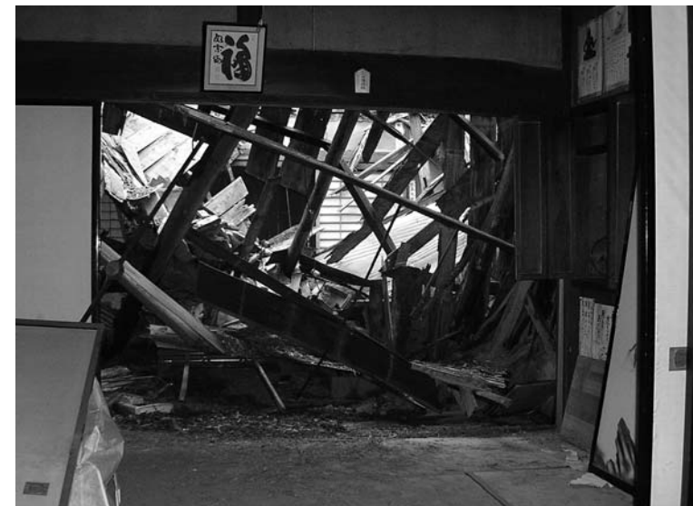
昨年8月の地震で倒壊した木造家屋（牧之原市）
