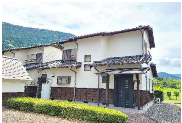
←周知用チラシ ↑お試し住宅外観
