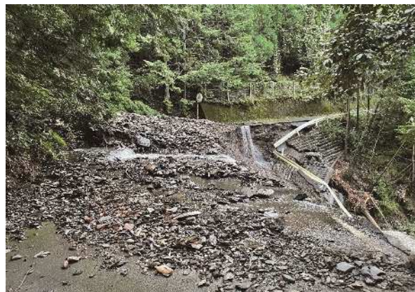
町道水川藤川線の状況
