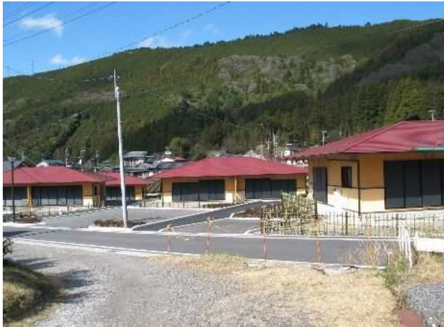
建設時の状況(全体)
