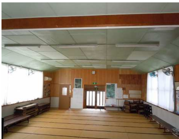
寺馬区会館 照明LED化改修
