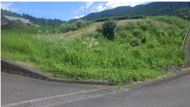
図 4: 急傾斜地などの危険な場所でも対応可能。
