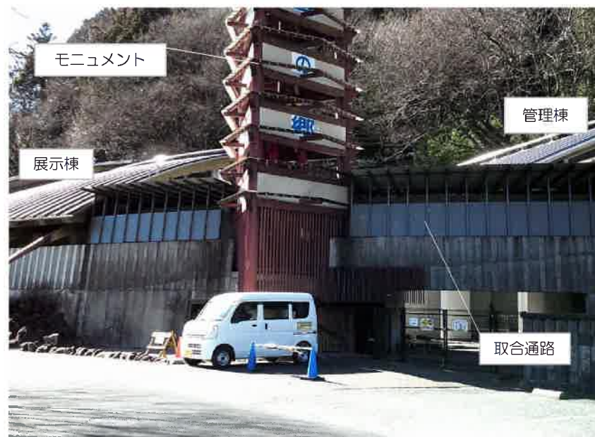
取合通路（駐車場方向から）
