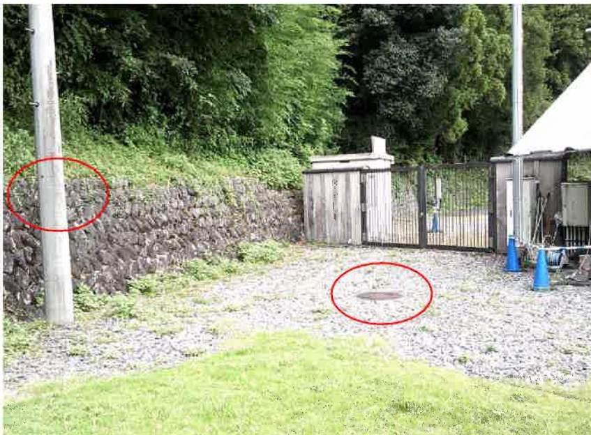
電柱、マンホール
