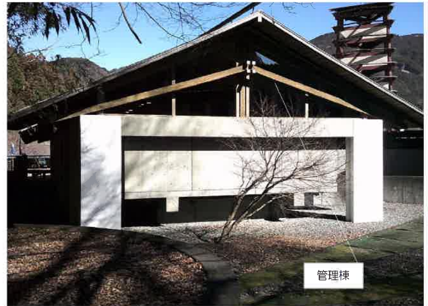
管理棟（裏側方向から）
