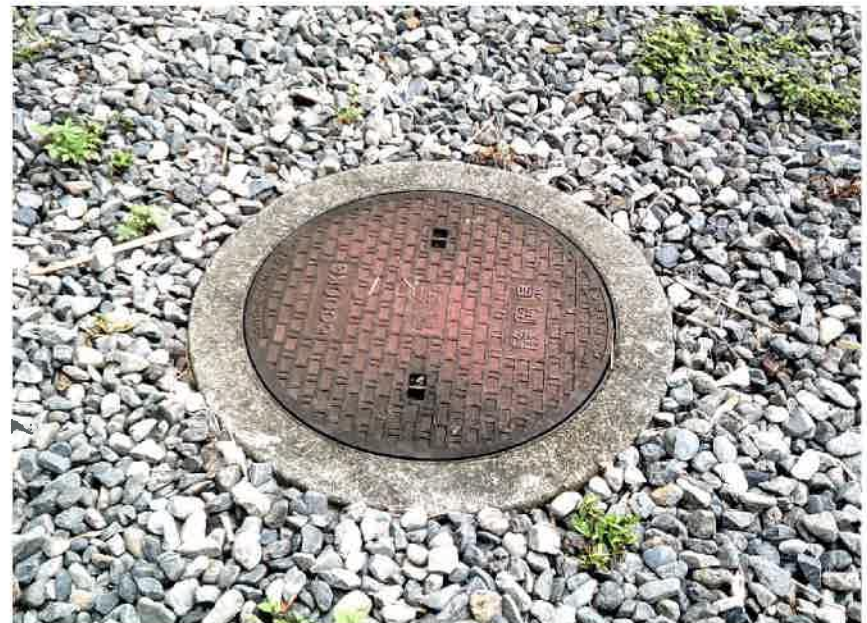
マンホール状況
