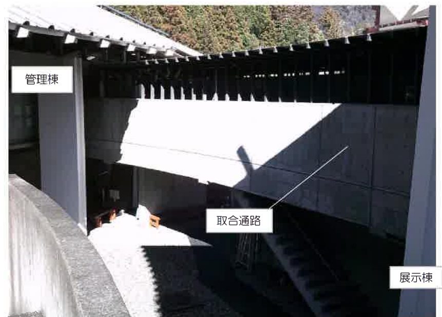
取合通路（中側方向から）
