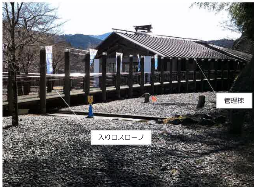
管理棟（正面方向から）
