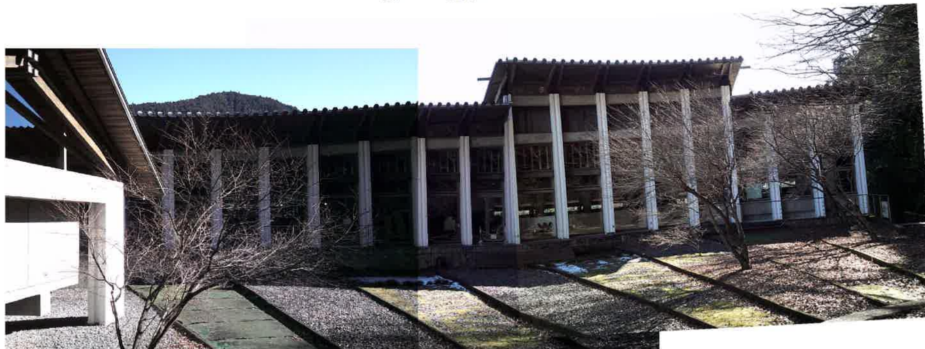
展示棟（中側方向から）
