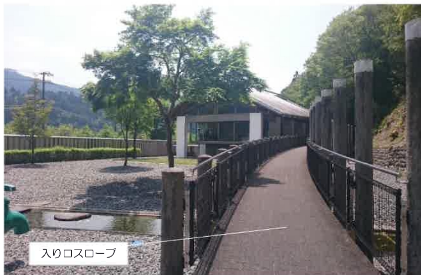
入り口スロープ（正面方向から）
