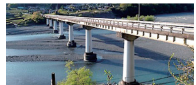
橋の下部を補修する中徳橋 上長尾⇄田野口
