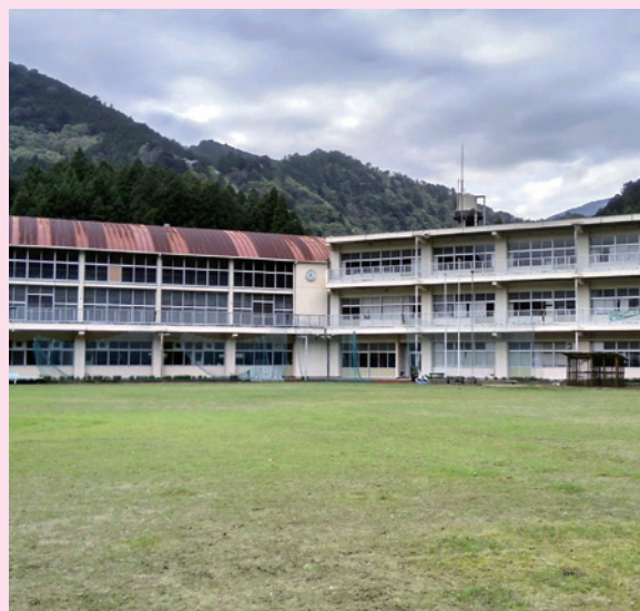
解体予定の旧北小学校
