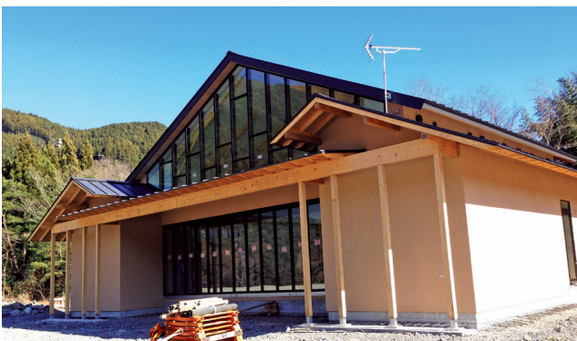
完成間近の「伝統文化伝承館」
