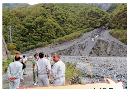
畑薙第1ダム上流部の赤崩の様子
