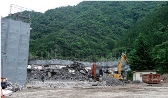
解体中の旧北小学校
