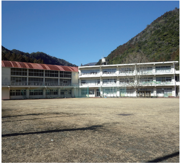
解体前の旧北小学校
