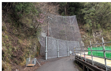
寸又峡プロムナードコース 落石対策工事の様子
