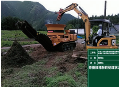
下泉原地区造成作業
