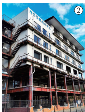
【震災遺構】たろう観光ホテル 低層階は津波に流された 被災当時のまま残されている
