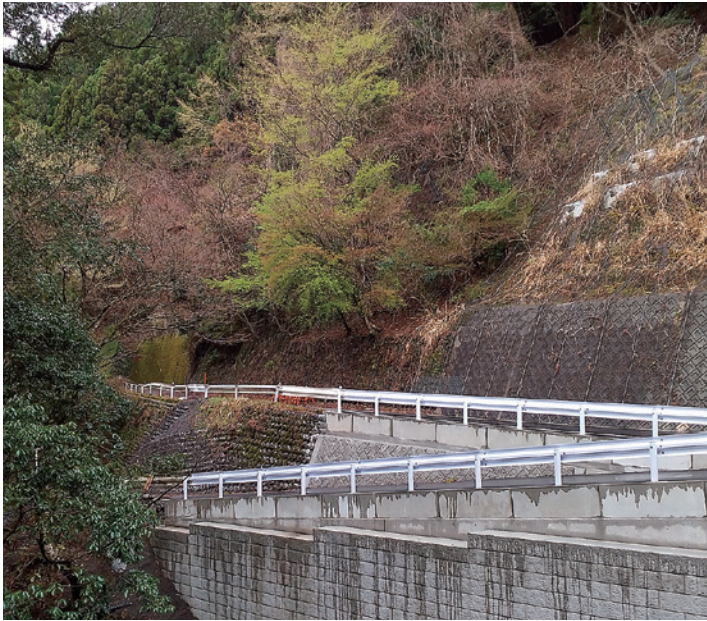
奥の山側斜面は国道362号地滑り現場手前 斜め左側は令和6年度に台風15号災害復旧工事で完了した林道西又線
