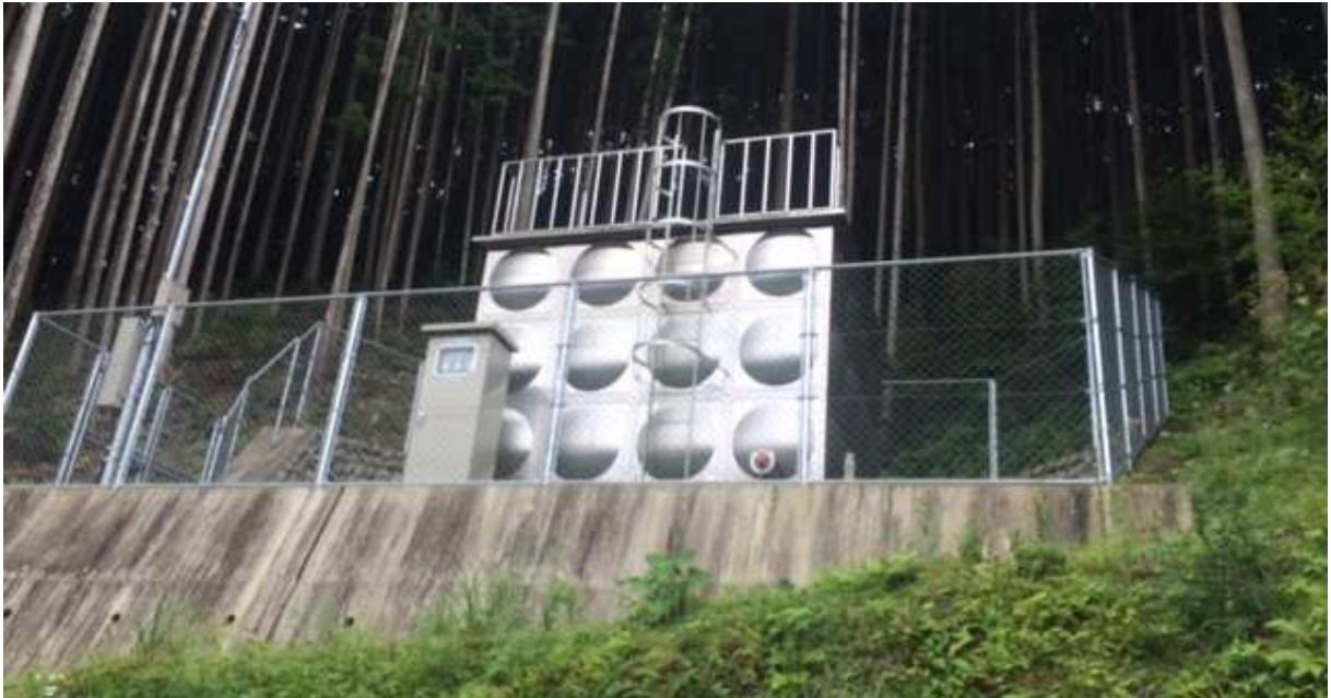
(田代配水池 平成 24 年 3 月完成)
