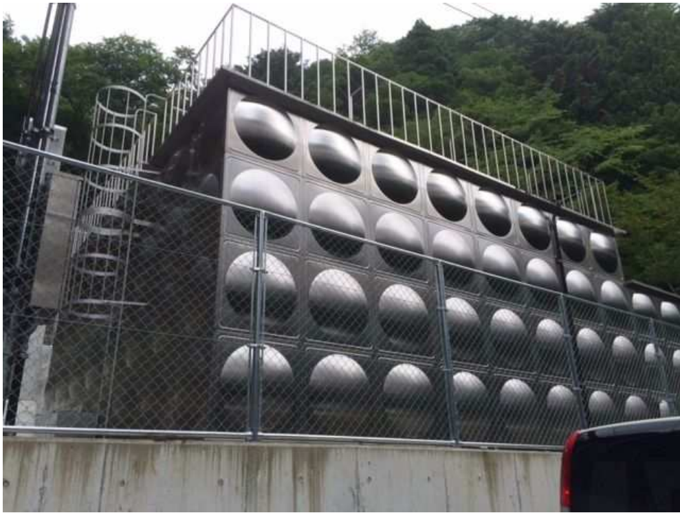
(大間配水池 平成26年3月完成)
