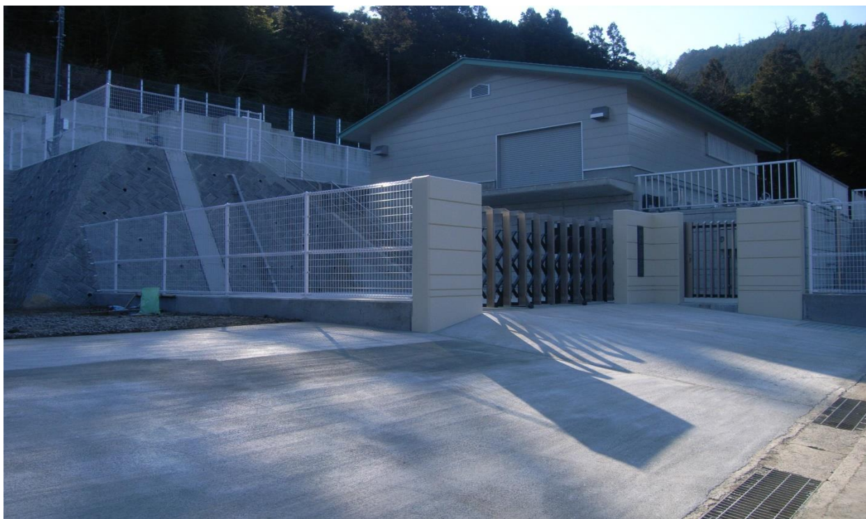
(田野口浄水場 平成20年3月完成)
