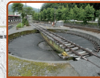
大井川鐵道転車台
