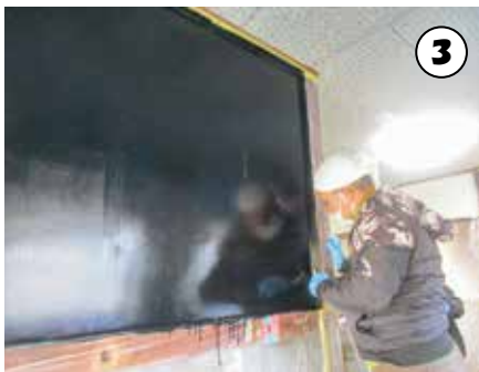
①_漆喰作りを行う参加者。②_下地を塗った上に白いペンキを塗る作業。③_黒板用の塗料を壁に塗る様子。
