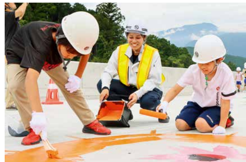
ローラーと刷毛で丁寧に色塗り
