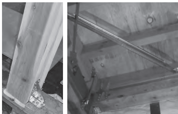
▲耐震補強工事における施工の一例
