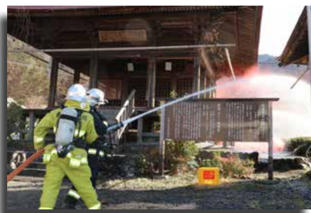
●火点へ向けて放水する消防隊員
