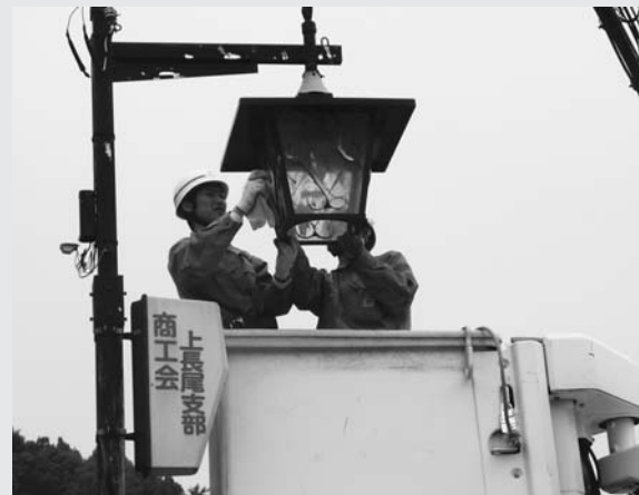
高所作業車を使い手慣れた様子で作業する参加者。
