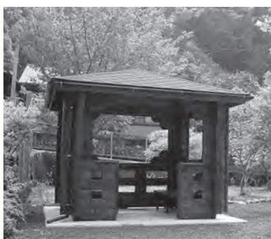
▲平成24年度「宮前公園整備事業」(大間区)
