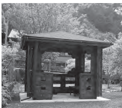
▲平成24年度「宮前公園整備事業」(大間区)
