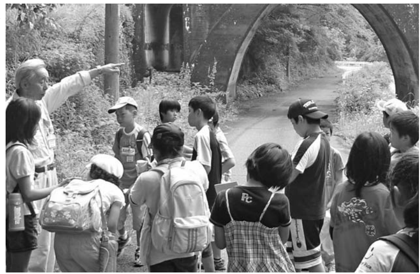
水路橋(上長尾)を見学しました。
