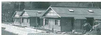
住環境の整備 町営住宅の建設 (地名)
