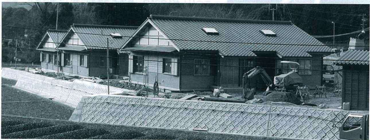
建設が進む地名住宅(2月上旬撮影)
