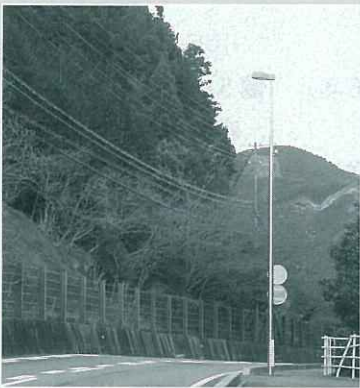
設置された照明灯の1基です。国道が明るくなります。
