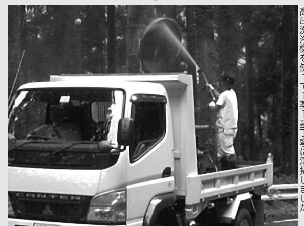
高圧洗浄機を使って1基1基丁寧に清掃しました。
