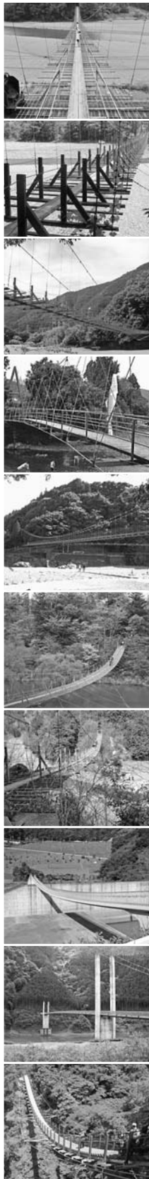
対象となる吊り橋 上から塩郷の吊り橋、ハマタ橋、青部の吊り橋、小長井吊り橋、両国吊り橋、夢の吊り橋、猿並橋、長島ダムしぶき橋、南アルプス接岨大吊橋、宮沢橋
