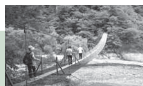
1 寸又峡 夢の吊橋
