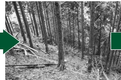
(整備直後)40㍻の間伐を実施
