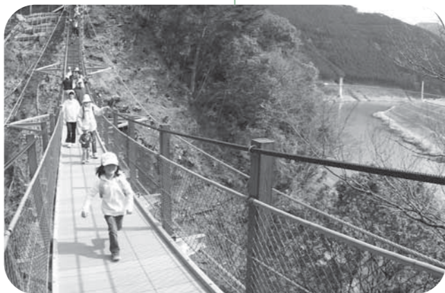
は水平距離が62メートルで、群馬県みどり市の「けさかけ橋」の51メートルを抜き、日本一の階段式吊橋（吊床板階段橋）となりました。
