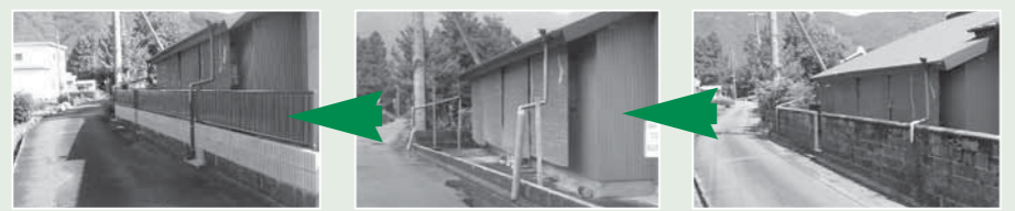
撤去施工例 元藤川のKさん宅 (補助金額10万円) ①撤去前 ②撤去後 ③アルミフェンスを設置 ※必ずしも必要ではありません
