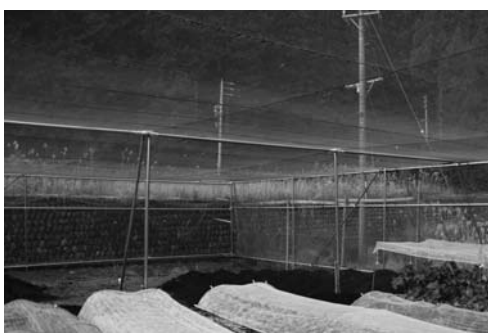
防護柵の設置例(写真上部)。実施はまず要望書から。
