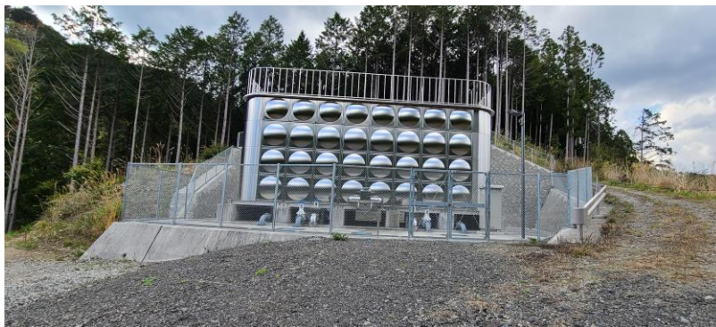
【本川根南部簡易水道・新小長井第2配水池】
