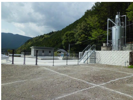
【地名簡易水道浄水場施設】
