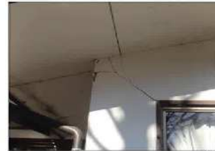
【モルタル塗り仕上等】 開口廻り部廻りにわずかなびみれが生じている。
