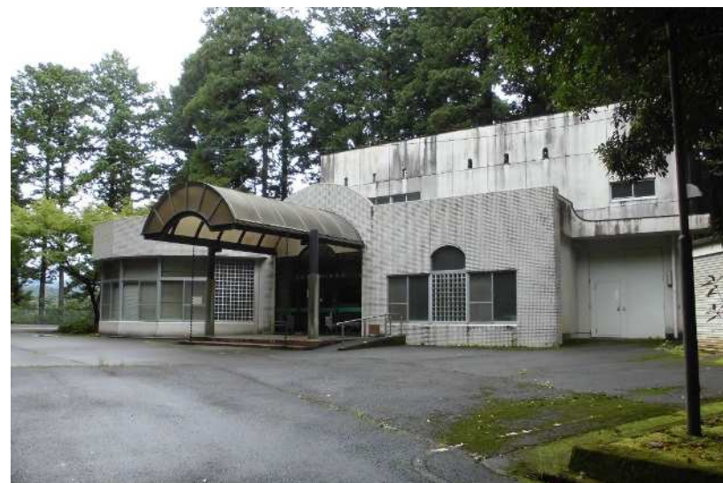
本川根斎場 昭和63年供用開始（築34年）
