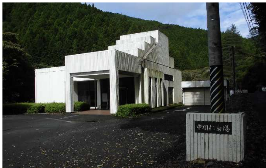
中川根斎場 昭和59年供用開始（築38年）
