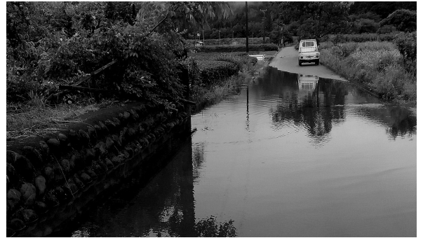
農道シマブレ線冠水状況 (6月3日)
