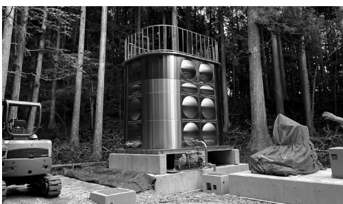
新設中の尾呂久保飲料水供給施設
