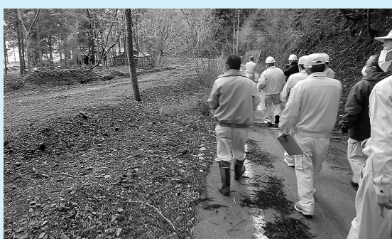
小河内川災害復旧工事現場
