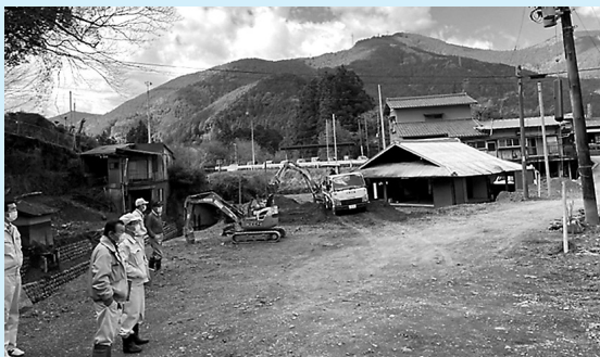
足間沢線災害復旧工事現場
