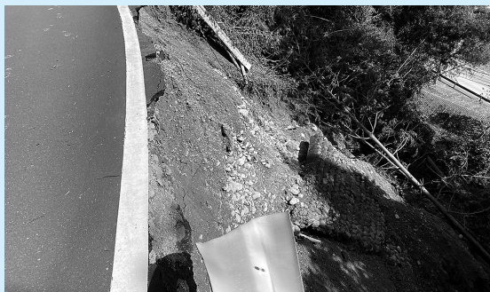
梅高中央線災害復旧工事現場
