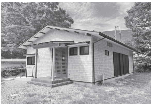
新しく完成した接岨地区集会所 23,650千円
