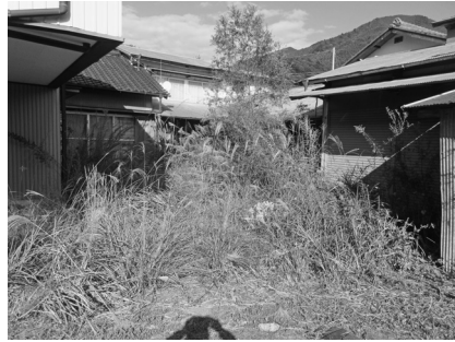
特定空き家とおぼしき建物の現況
