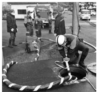
消防団分団員によるポンプ点検(毎月1回) 桑野山区にて
