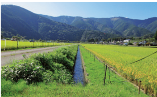
地名用水法面の状況
