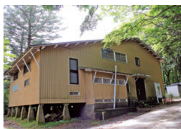
静岡大学農学部演習林宿舍 (昭和44年建設)
