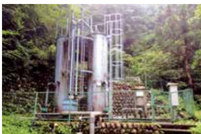
水道施設（接岨浄水場）
