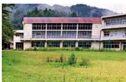
15年が経過する元北小学校
