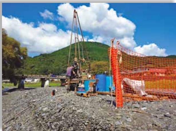
国道362バイパス・上長尾橋脚調査ボーリングが始まる （9月27日）
