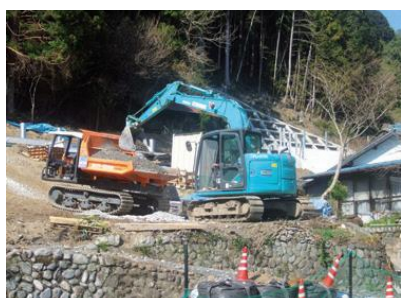
水川区 急傾斜地工事現場
