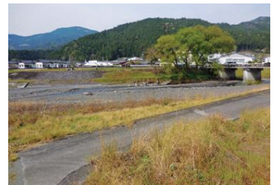
新長尾川橋詳細設計着手へ(上長尾バイパス)
