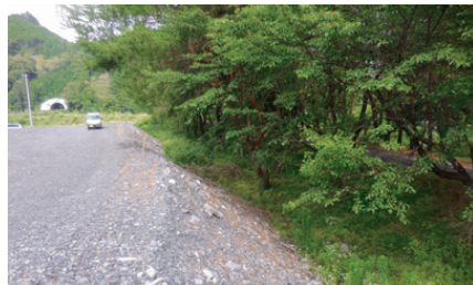
造成地護岸工事予定地
