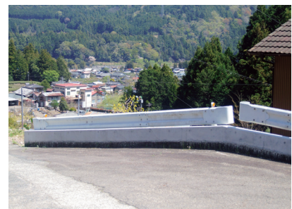
西平地区の工事箇所
