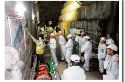
井川ダムの堤体内部で構造等について説明を受ける。
