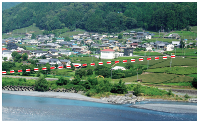
早期の整備が待たれる上長尾バイパス整備予定区間
