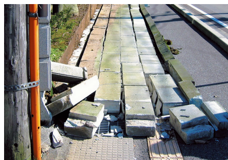
注) 写真のブロック塀は町内のものではありません。
