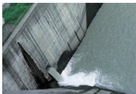
長島ダム排水口が湖底からの汚濁水
