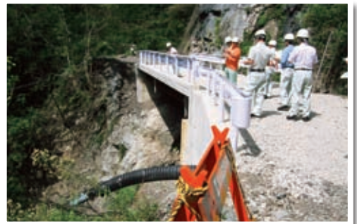
<寸又峡プロムナードコース(夢の吊橋)現地調査>
